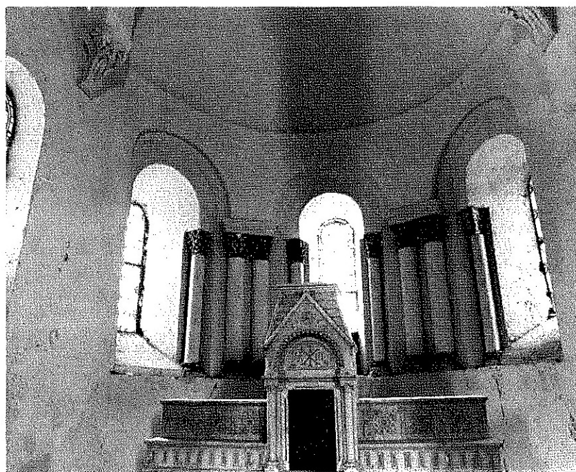
(cliché « Sud-Ouest ») FIG. 2. — Lanton. Intérieur du chevet de l'église.
